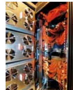
Optische Kabel und wassergekühlte Türen. Allein die zweite Ausbaustufe hat 4.500 Kabelverbindungen mit einer Gesamtlänge von 45 km.
